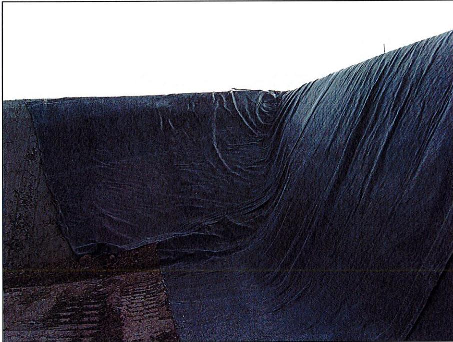
**Figura 4:** Posa in opera del geocomposito bentonitico
